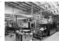
5 Baffles en panneaux acoustiques de laine minérale dans une entreprise produisant des boissons (installation de remplissage).
